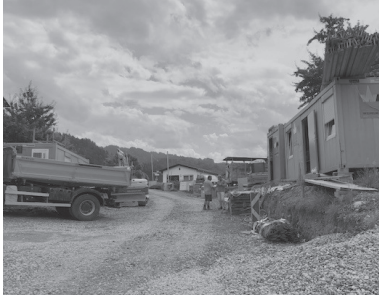
Teil 1 der Sanierung L51 Latenser Straße
