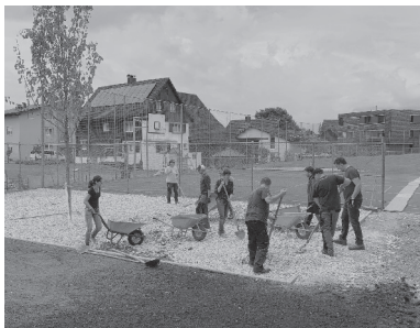
Fleißige Helfer bei der Errichtung des grünen Klassenzimmers
