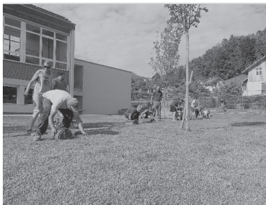
Verlegung des Rollrasens
